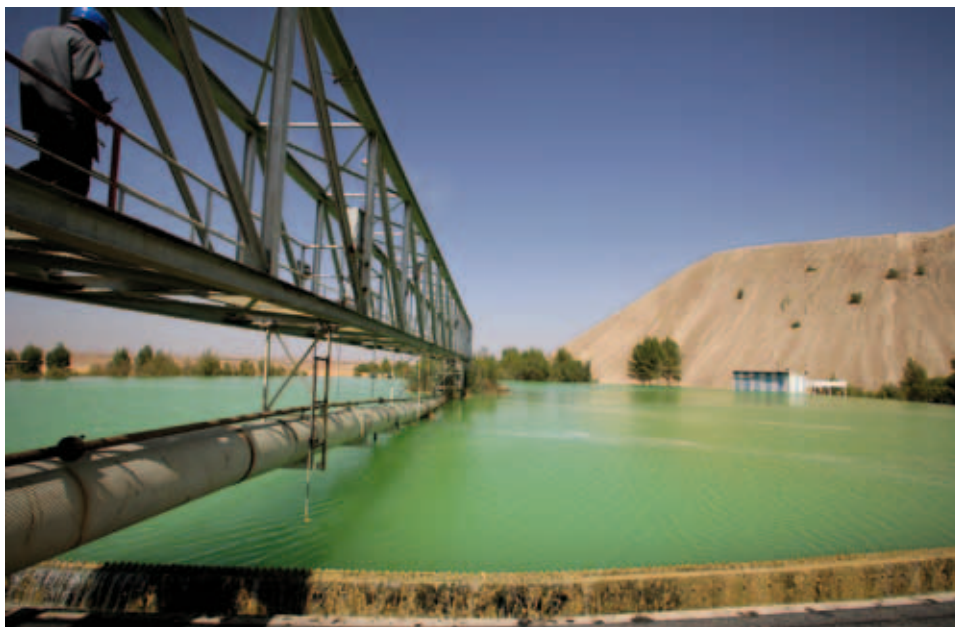
Stratégie eau : usine de flottation à Khouribga
